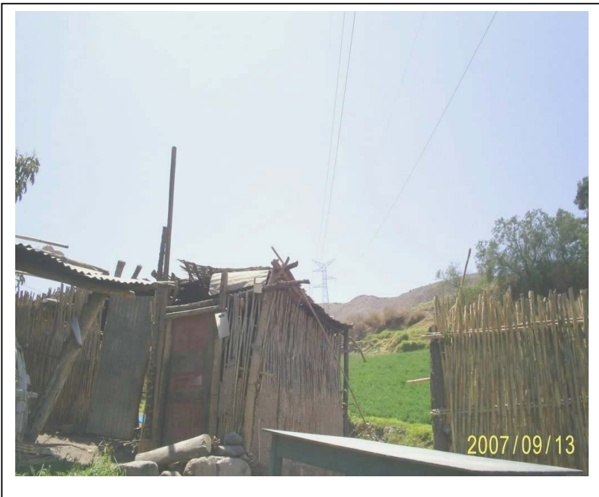
FIGURA N° 02 (Vista Torre N° 399 (al fondo): Se aprecia la vivienda precaria invadiendo la faja de servidumbre)
